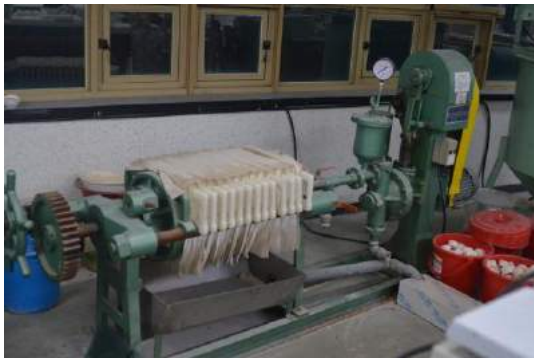
〈그림28〉 필터프레스와 멤브레인 펌프
