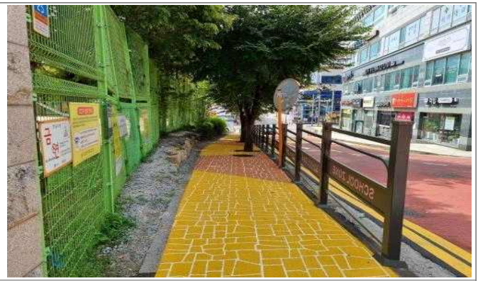
공사 후(도로 휨스 및 수목)1
