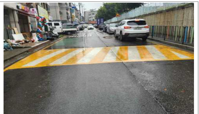
통학로 안전시설(미끄럼방지 포장) 대상 현장 사진
