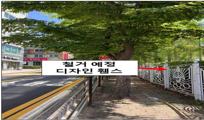
공사 전(도로 휨스 및 수목)1
