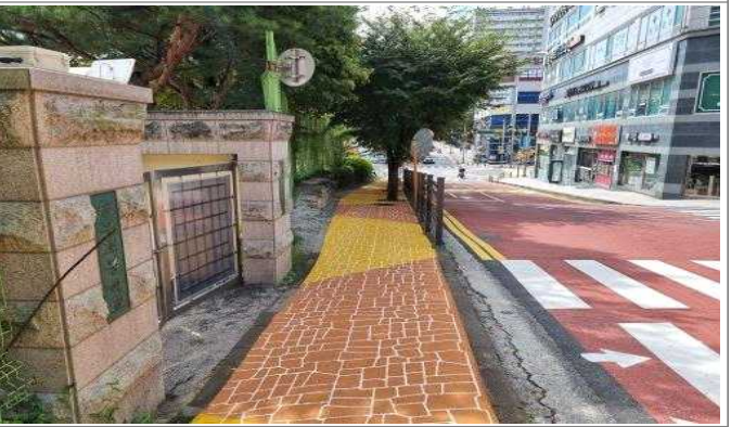
공사 후(도로 휨스 및 수목)2
