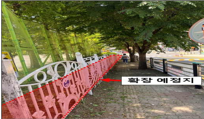
공사 전(도로 휨스 및 수목)2
