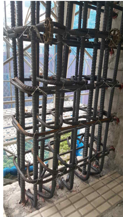
(b) 날개벽내의 후프철근의 시공
